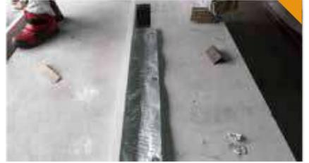
固定ピン台座と固定ピンの中間部に接着剤を塗布し、床面に固定してください。
