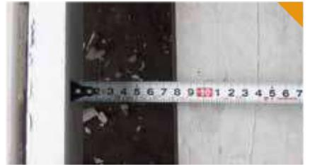
施工する現場の床層間幅をメジャーで測定してください。
