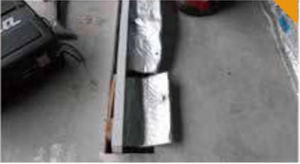
隣り合うレイガードを製品長さ方向の圧縮代が見えなくなるまで押し付け、同様に施工してください。
