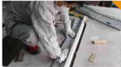
レイガードを幅方向に潰しながら床層間部に製品厚さ分を充填してください。
