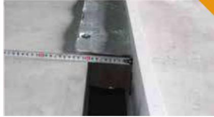
隙間が見えなく、隣り合うレイガードも十分に圧縮されていることを確認し、施工完了です。
